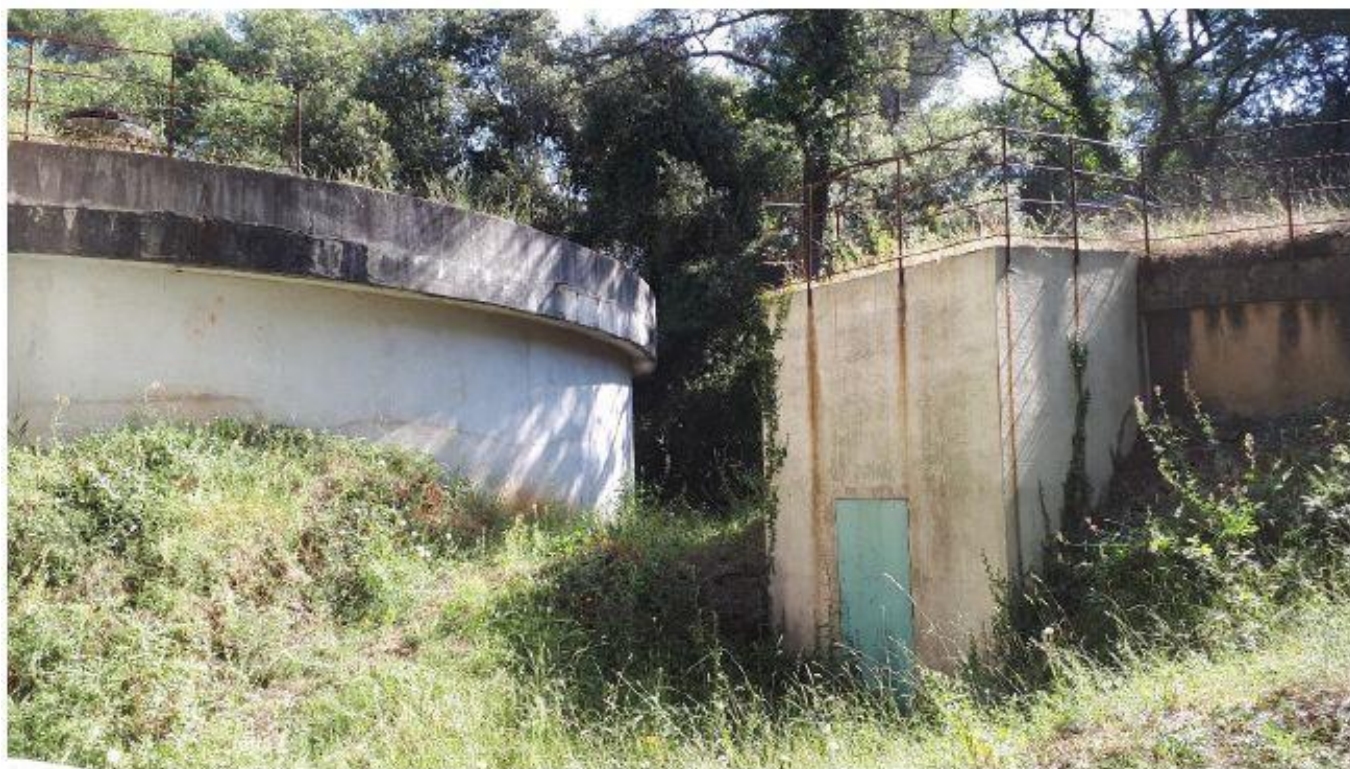
Réservoir des Gardettes
