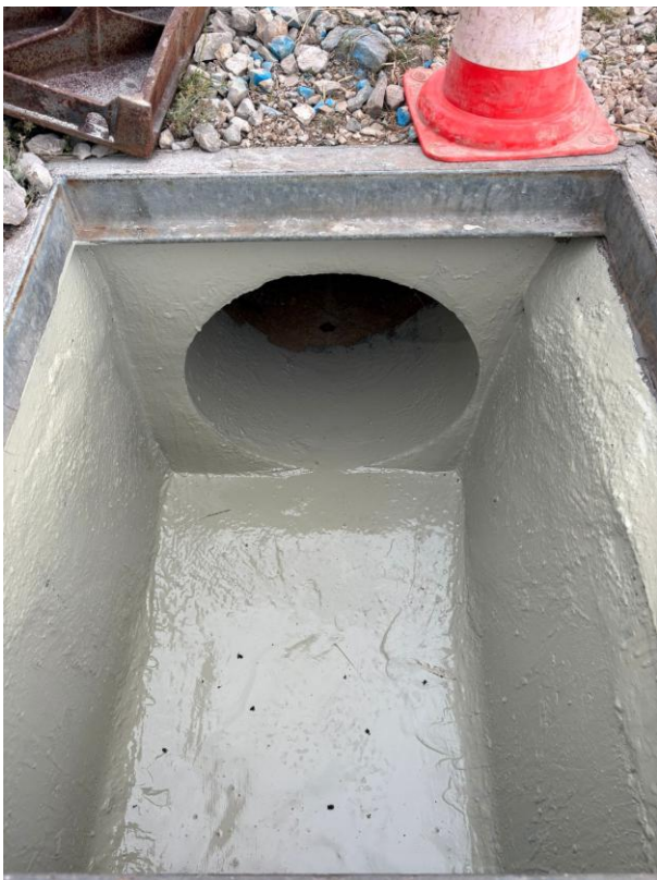
Canal du Vegay (Arrivée Usine à Bouyon) – Reprise des regards fuyards
